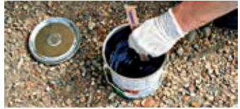
Rør i basen
