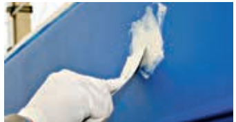
Påføring av sparkel med spatel
