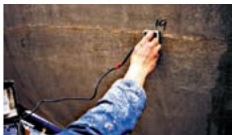
Måling av fuktighet
