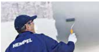
Påfør Hempel's Underwater Primer på de forbehandlede overflatene
