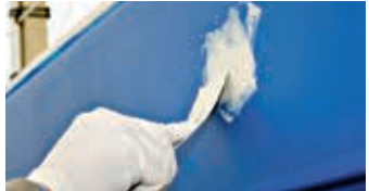
Påføring av sparkel med spatel
