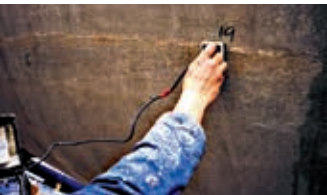
Måling av fuktighet
