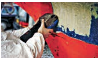
Fjerning av gelcoat med gelcoathøvel
