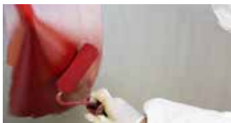
Påføring av bunnstoff
