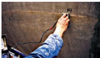
Måling av fuktighet
