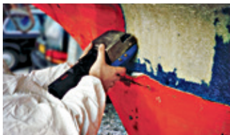
Fjerning av gelcoat med gelcoathøvel
