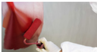
Påføring av bunnstoff
