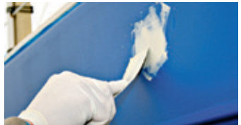
Påføring av sparkel med spatel
