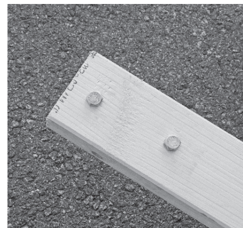
12 Sett i skruene UTEN skiver på hodet av skruene.
